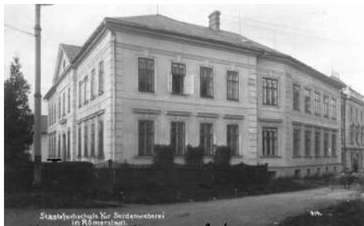
Budova gymnázia na Sokolovské ulici
